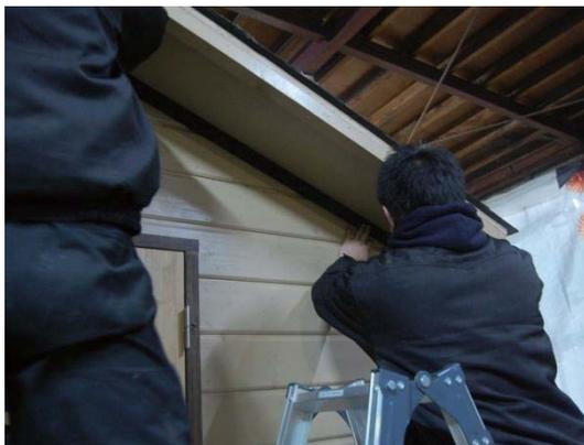
屋根周りの補強材を取り付けます。
