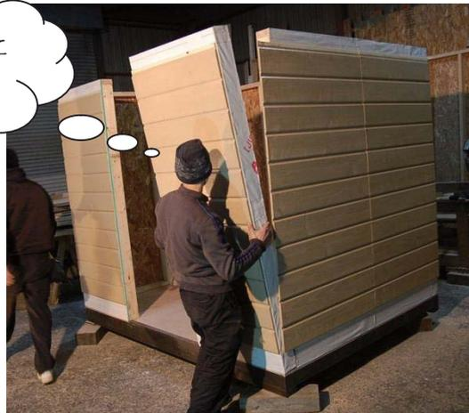
割れぼうしのため、はずしておいた一番下の外壁材を下から押し上げ、はめ込みます
