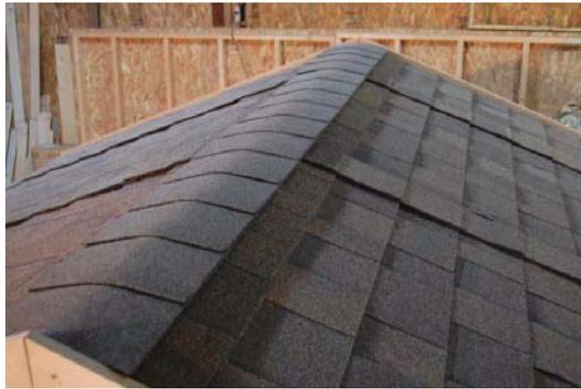
飾り破風を取り付けます。屋根よりも1～2センチ程上に上げて取り付けるとキレイです。
