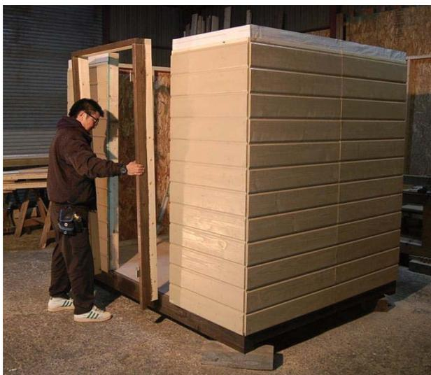
最後に入口の枠を取り付けます。
